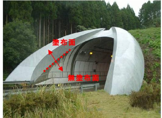
写真二 雨天時の吸水防止状況
