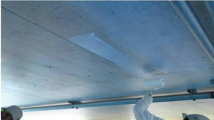
写真一 塗布状況（橋梁床版下面）
