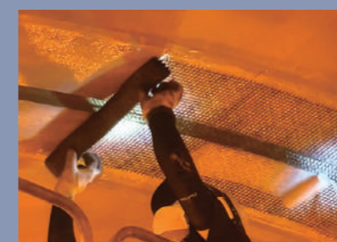
〈施工中〉BMシート貼付
