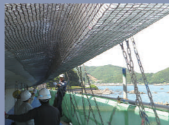
〈施工完了〉隅角部が密着している
