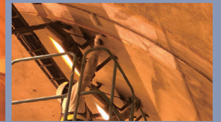
〈施工中〉1層目塗布の様子
