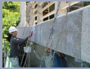
〈施工中〉BMシート工法の施工の様子
