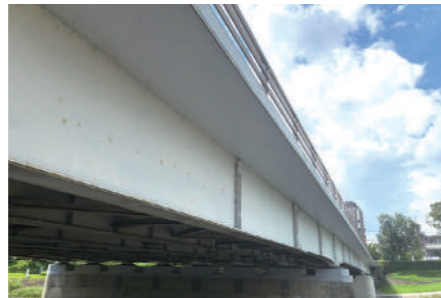
京都市役所 北山大橋補修工事
