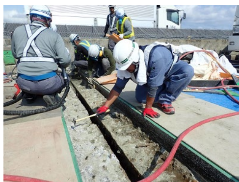
写真2 はつり面確認状況
