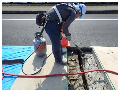
写真3 はつり面乾燥状況
