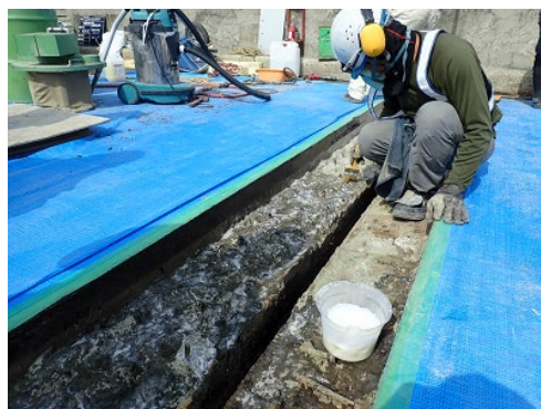
写真4 AEシール塗布状況
