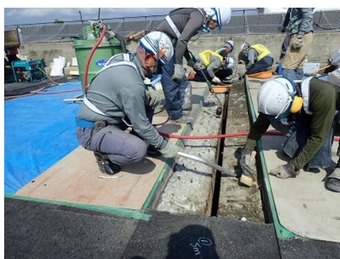
写真1 下地処理状況
