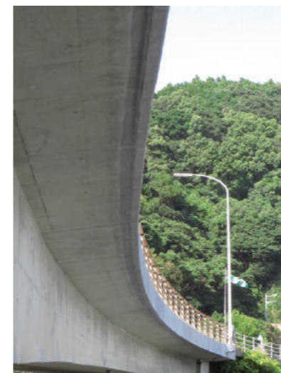
写真-1 床版下面張出部の様子
